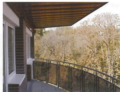
Ein Blick aus dem Atrium
