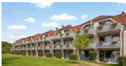
Seniorenwohnanlage in der Paschenburg (II)
